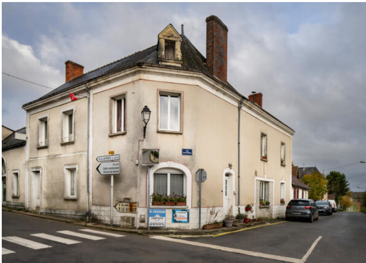
Maison et ancienne boutique, angle de la rue de Lucé et de la rue des Anfrières.
