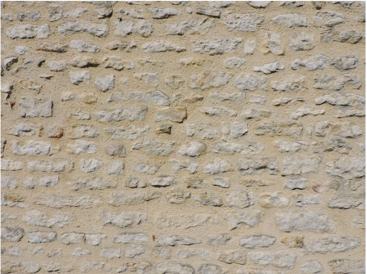
Mur de moellons partiellement enduits, rue du Bourbia.
