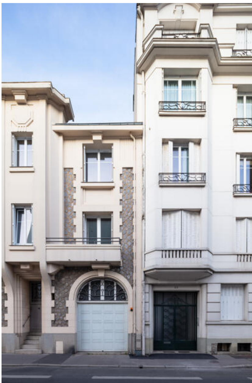
Vue de la travée nord de l'immeuble.
