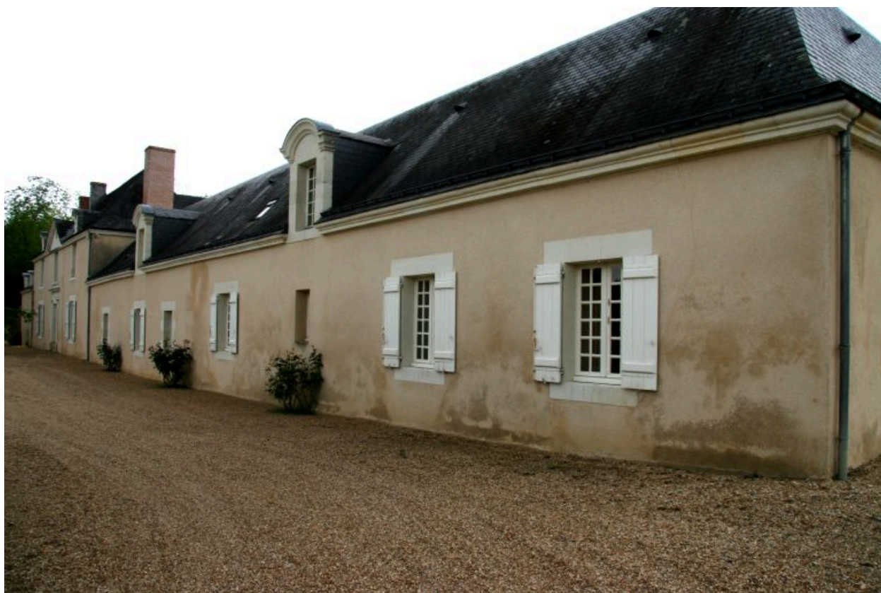
La ferme : façade postérieure remaniée.
