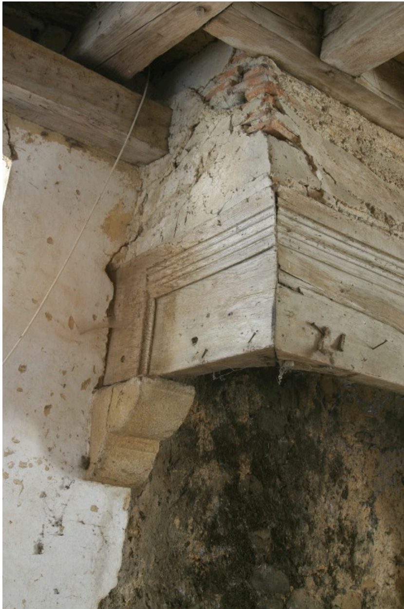
Etage. Petite pièce : détail de la partie gauche de la cheminée.
