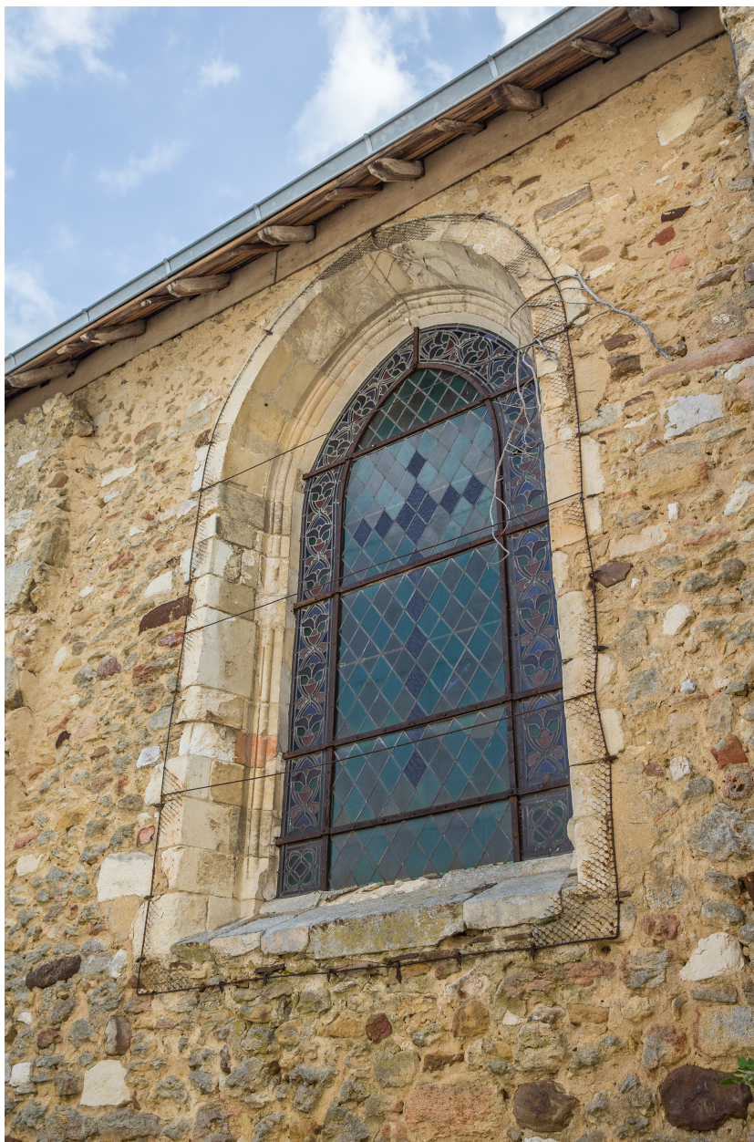
Une fenêtre en arc brisé, mur nord de la nef.
