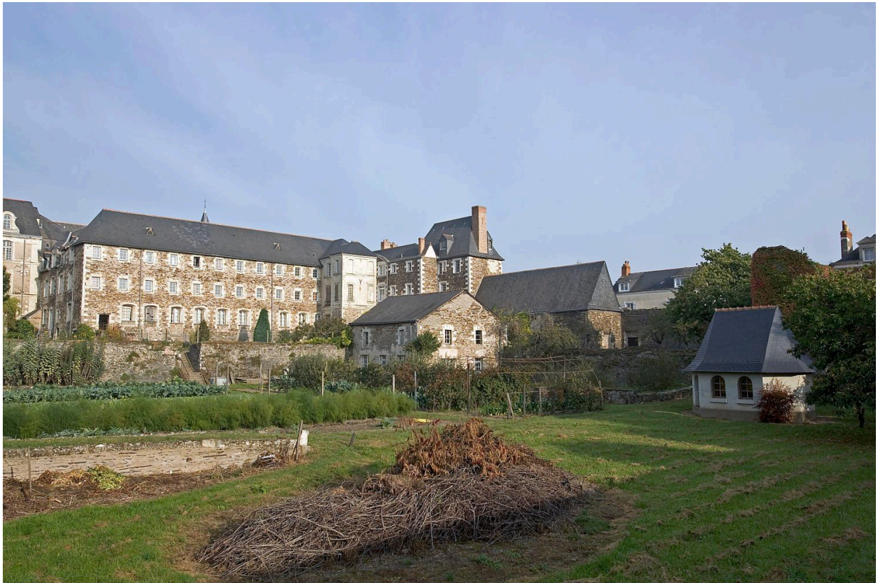
Vue d'ensemble des parties anciennes du couvent depuis la ferme.
