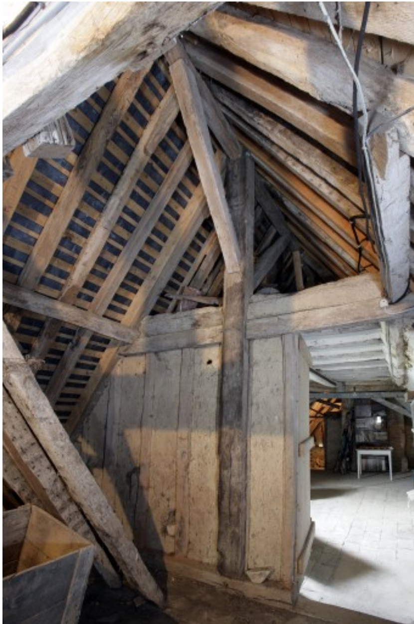
La charpente du corps sud vue depuis l'est.
