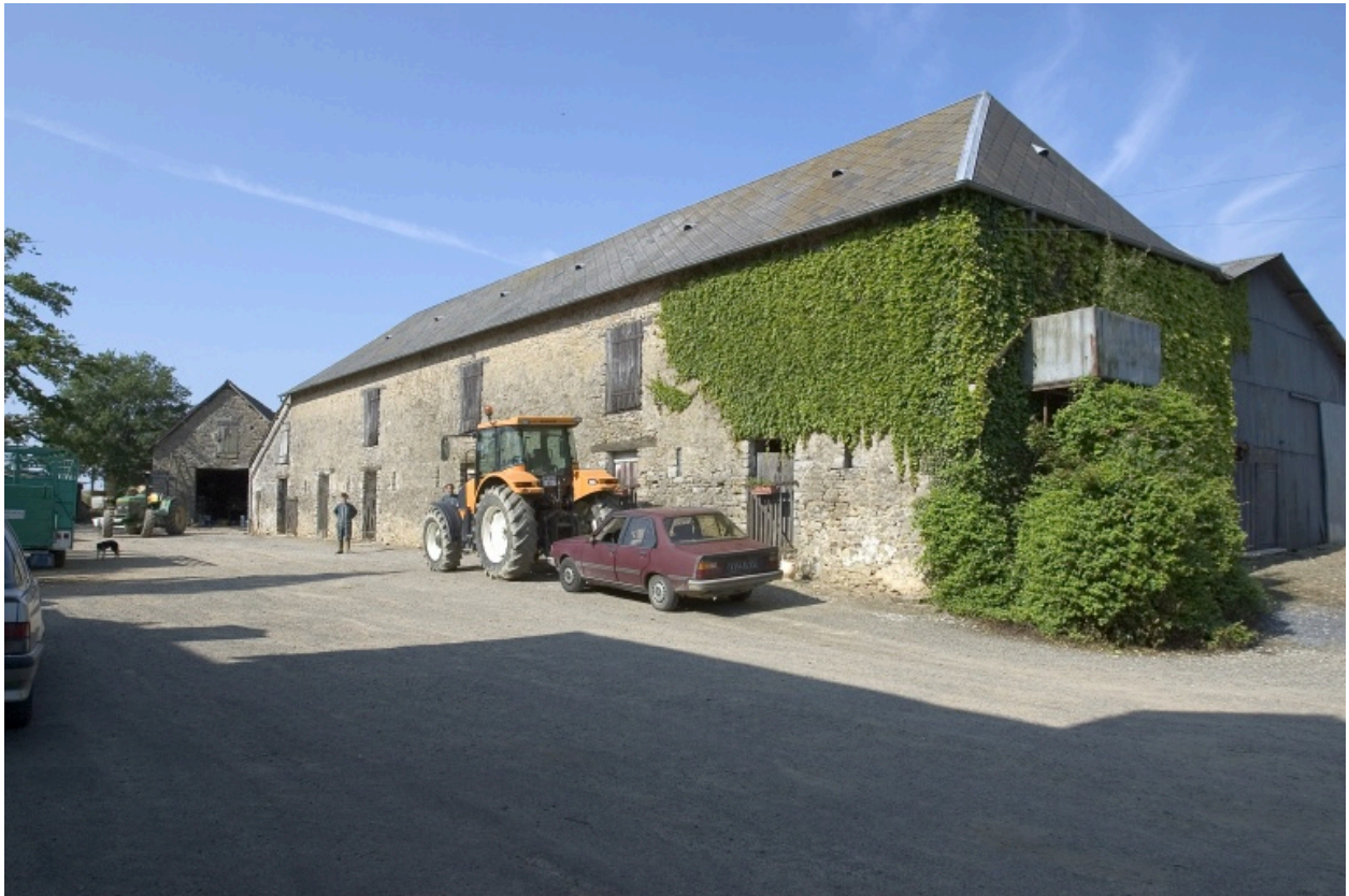
L'étable-grange et la remise
