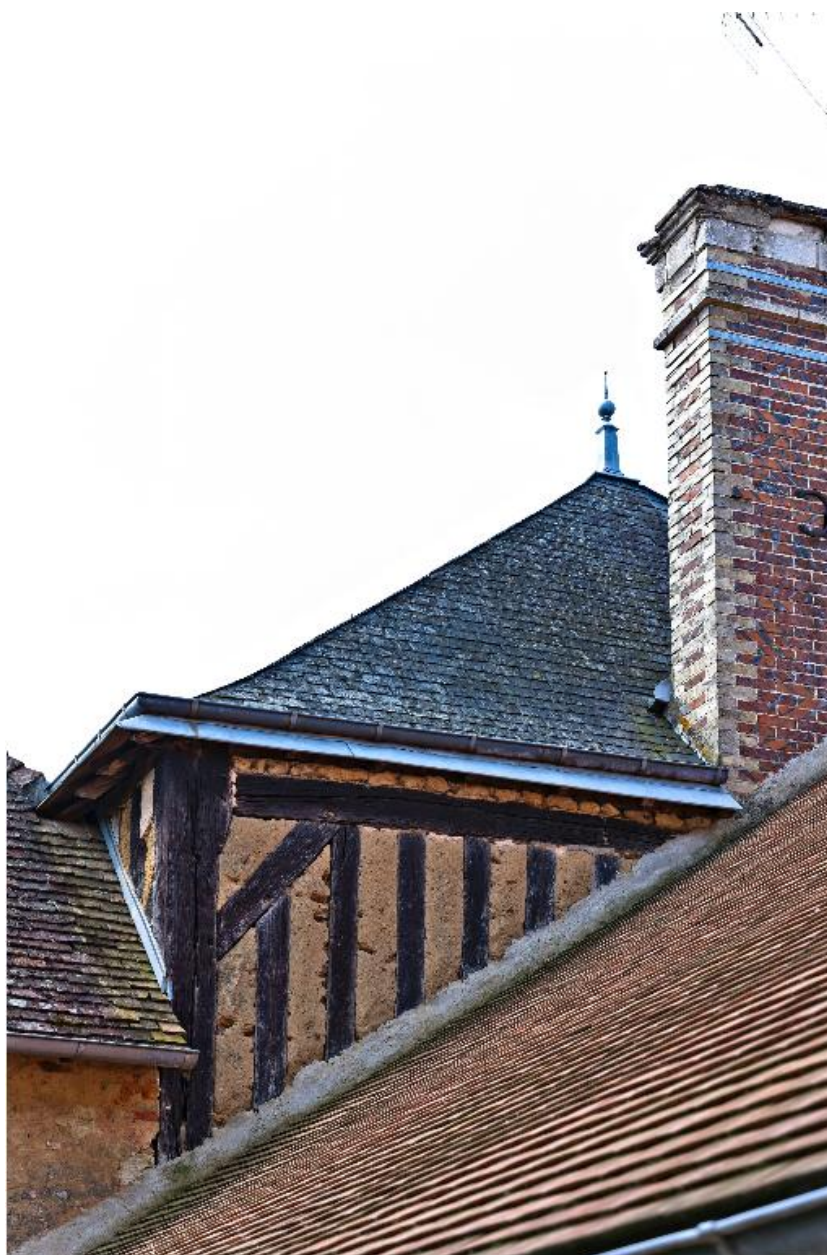
24, rue Basse. Détail de l'élévation postérieure en pan-de-bois de la maison.
