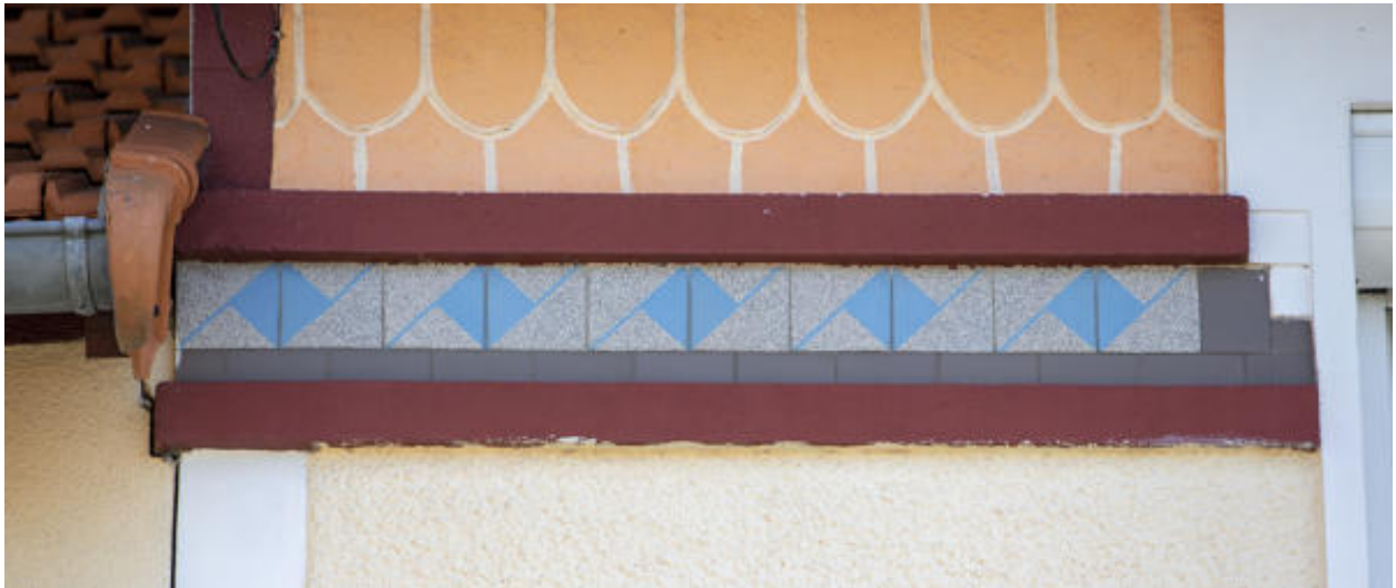
Détail de décor de carreaux de ciment sur la façade de la maison dite "villa de l'avenir" rue des Vergnes.
