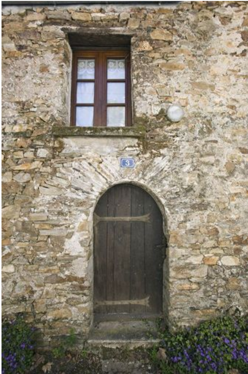
Porte cintrée à arc de schiste et fenêtre à linteau de bois, 18e siècle. (La Bourchinière).
