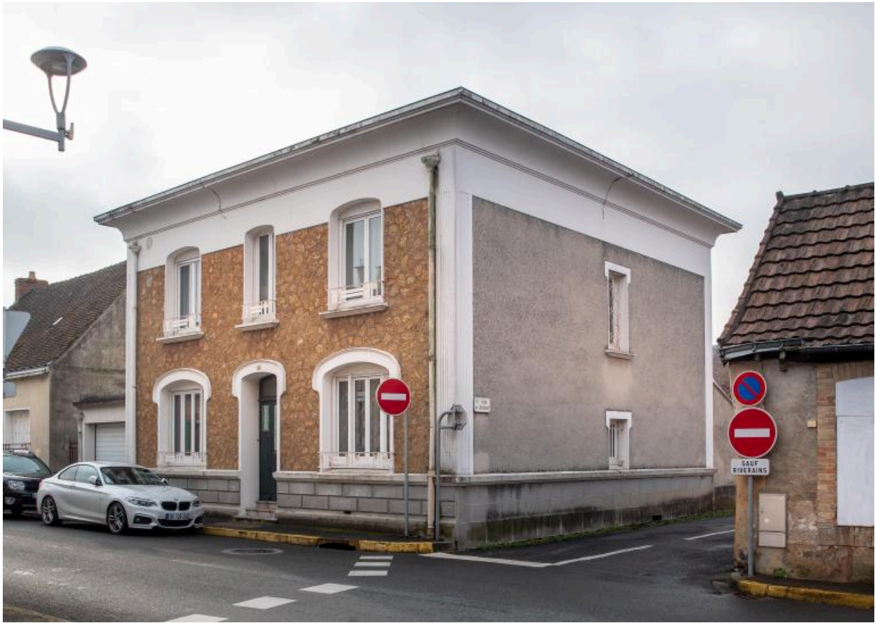
Les façades principale et latérale.
