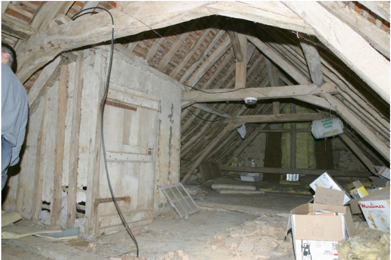
Première ferme, maison de maître : la charpente vue de l'ouest.
