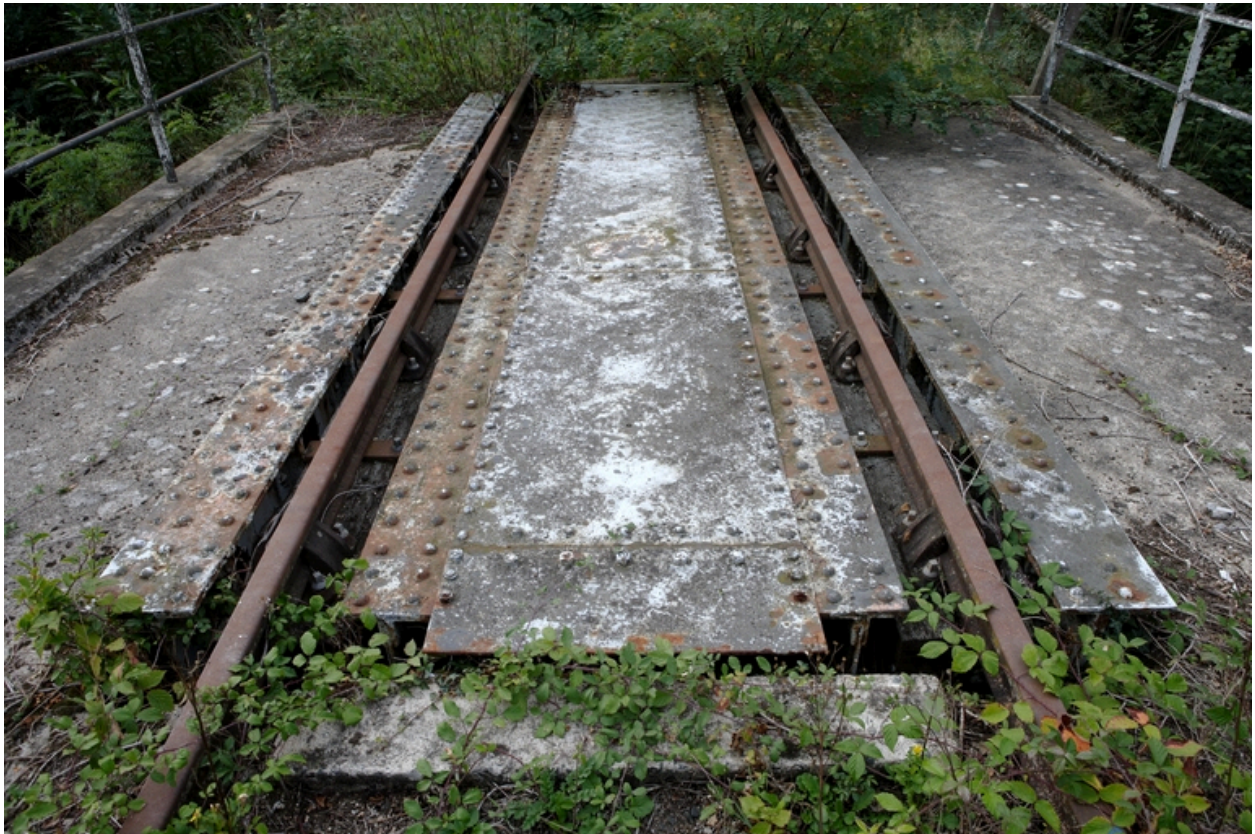
Tablier : accotements, poutres et entretoises, vue supérieure.
