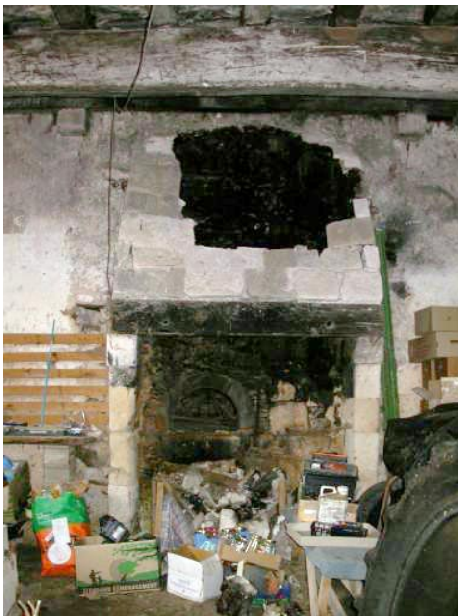
Cheminée de la grande salle.
