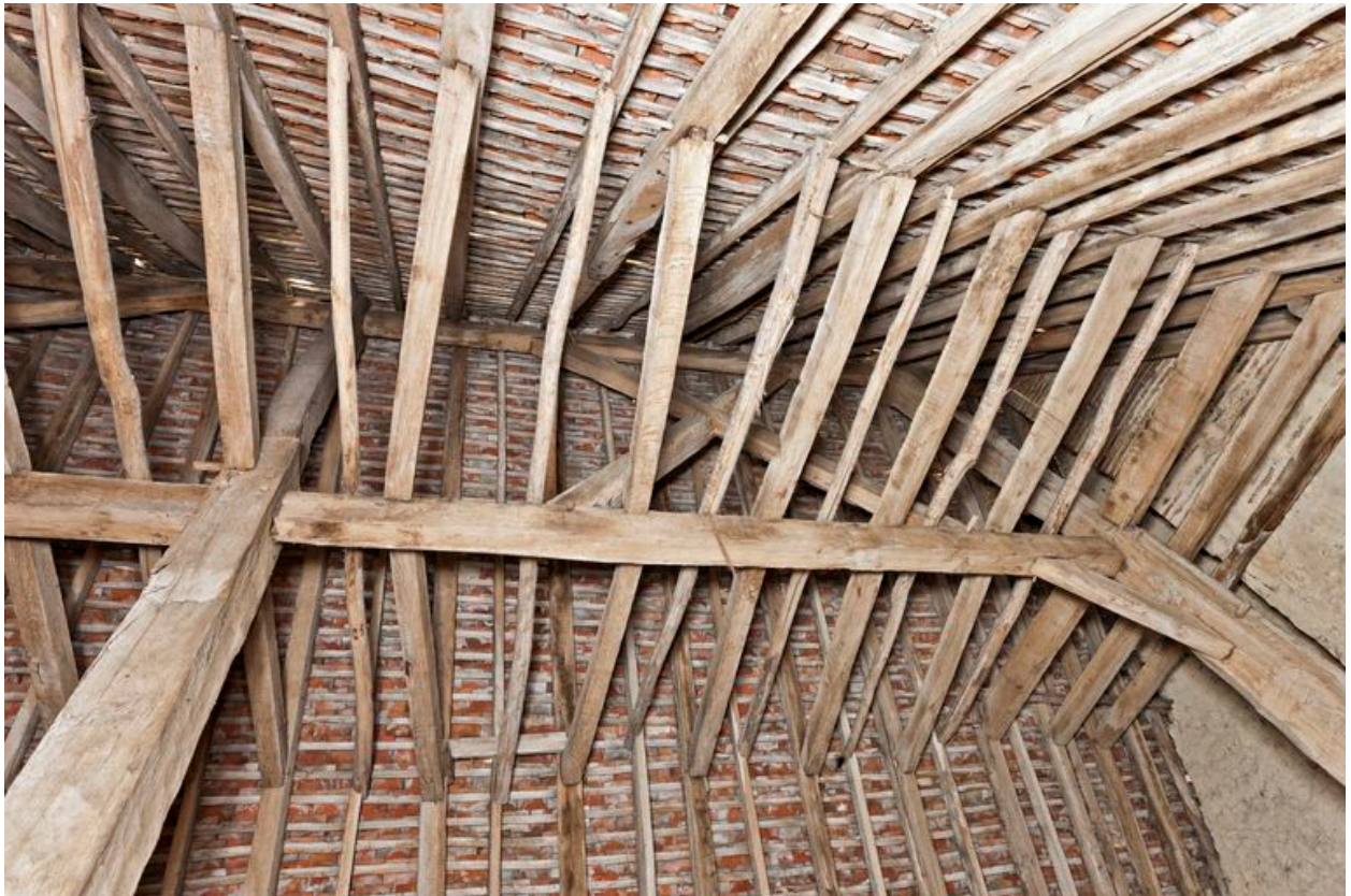
Détail du faitage de la charpente.
