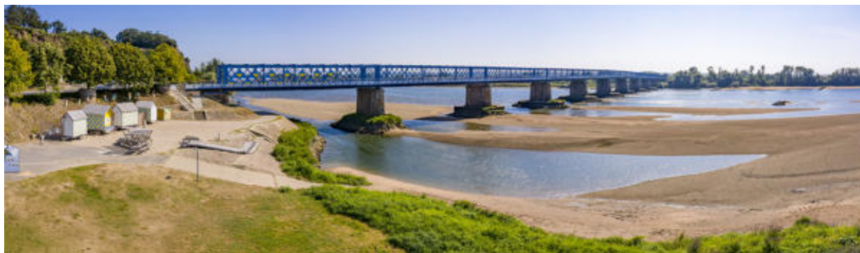
Vue générale de la cale aval et du pont de Mauves.
