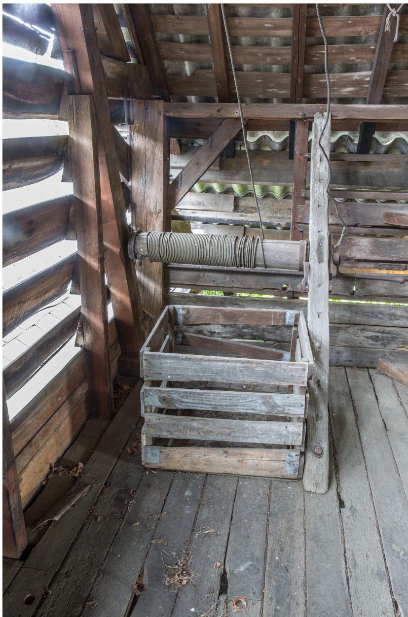
Un treuil à l'étage du séchoir.
