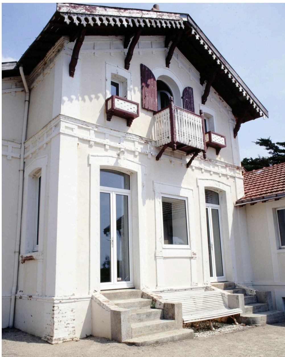
Elévation sud, partie centrale.
