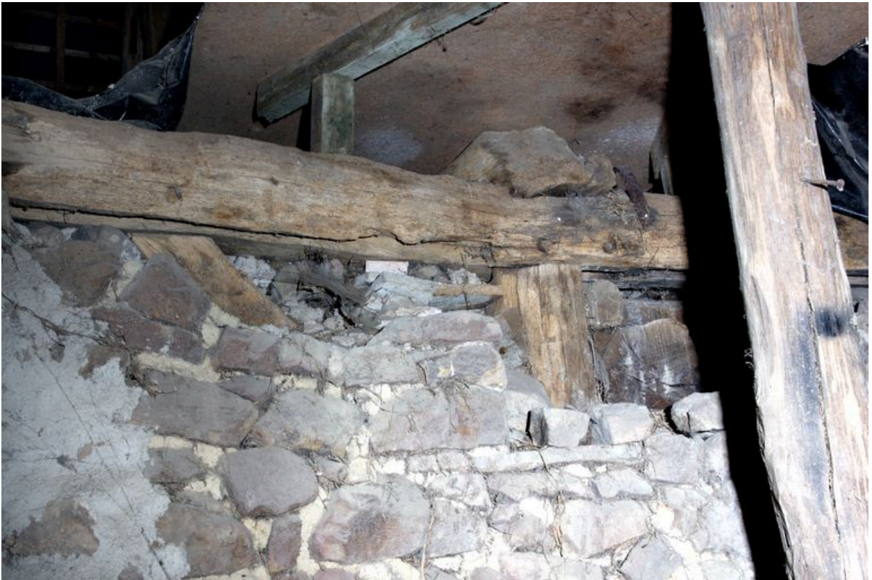
Détail du pan de bois du mur nord de l'ancien logis : la sablière et les extrémités du poteau et du lien oblique vus depuis l'extérieur.
