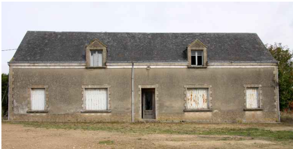
La maison d'habitation : façade sur cour.
