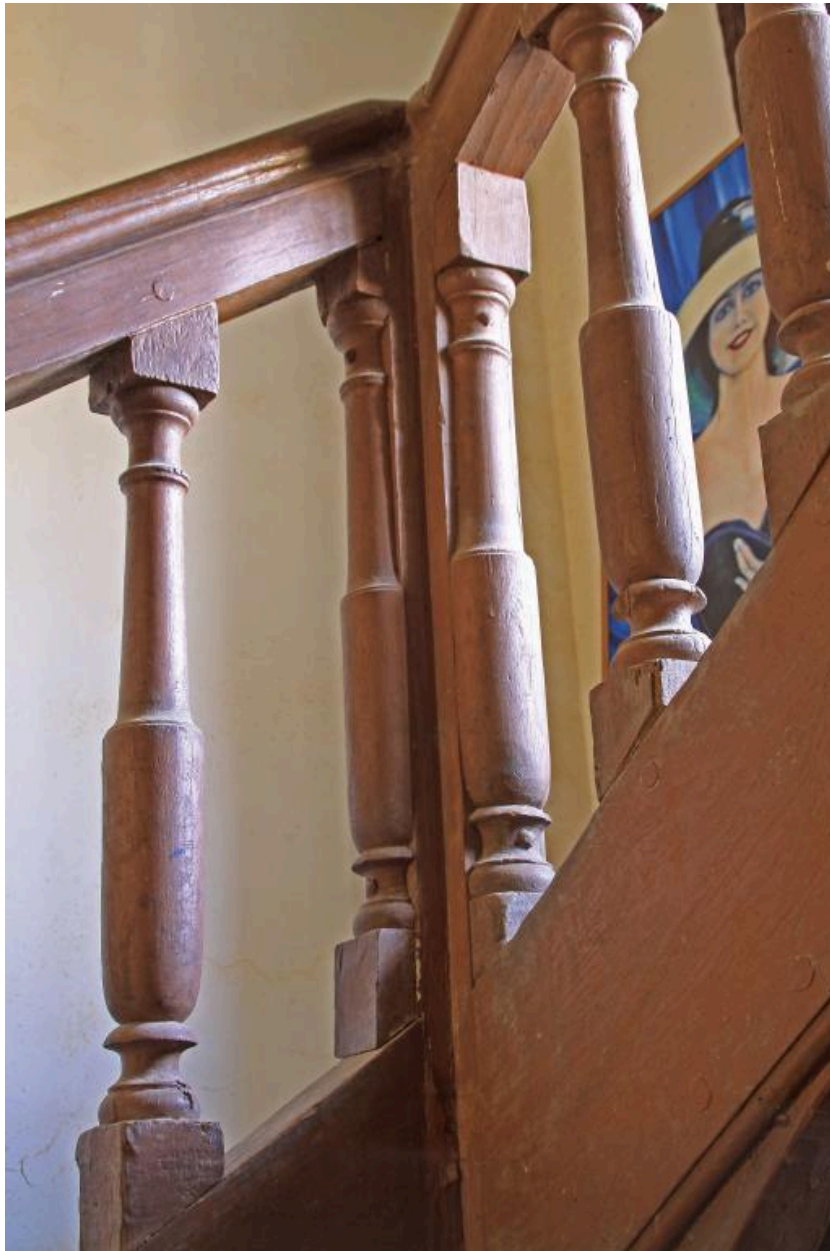
Vestibule, escalier : détail des balustres.
