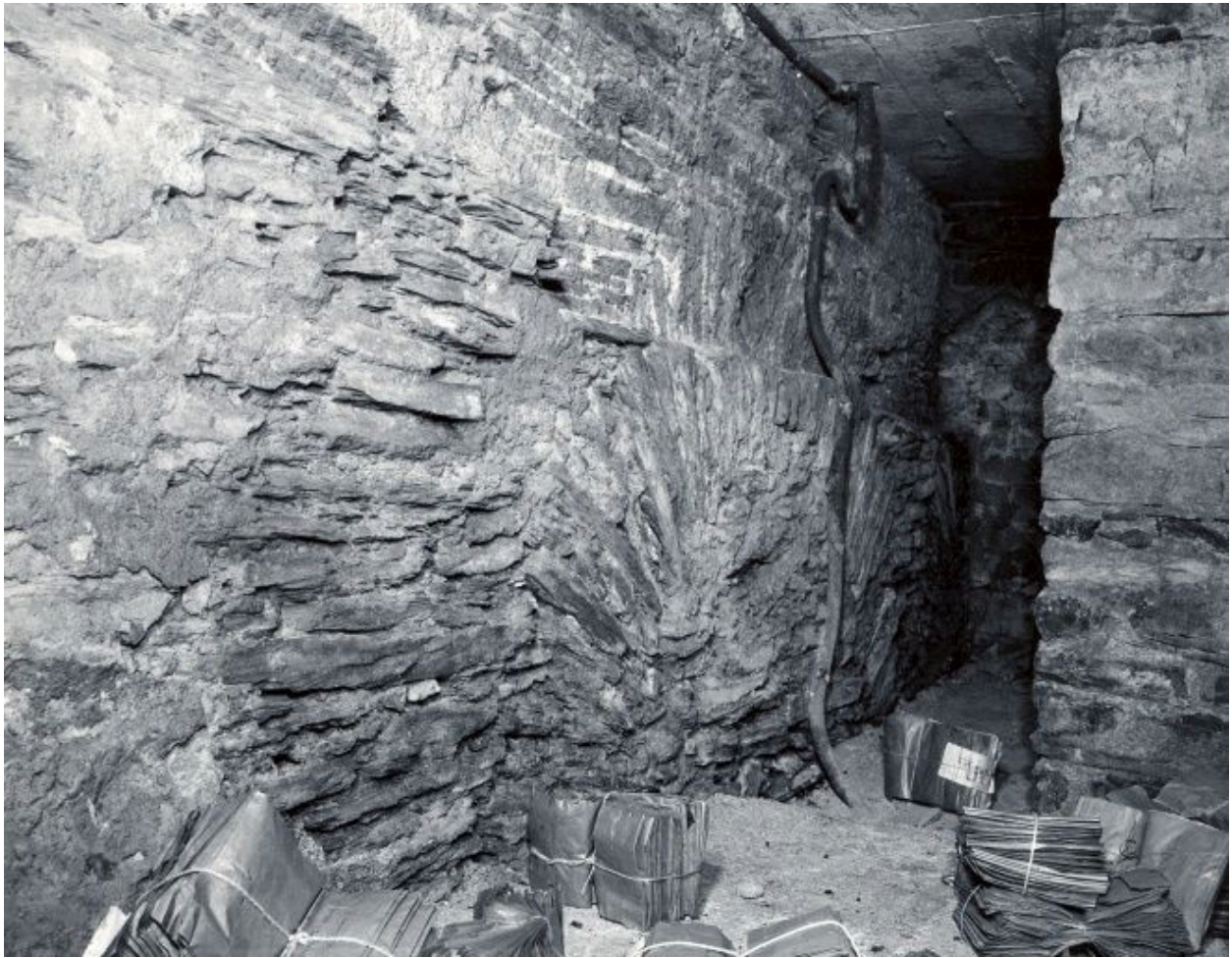
Second sous-sol, arc de schiste.
