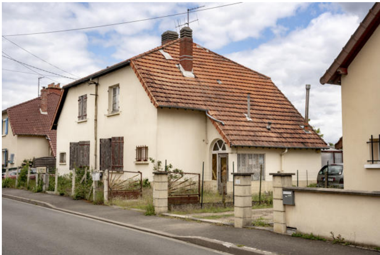
Vue de pavillons jumeaux pour ouvriers.
