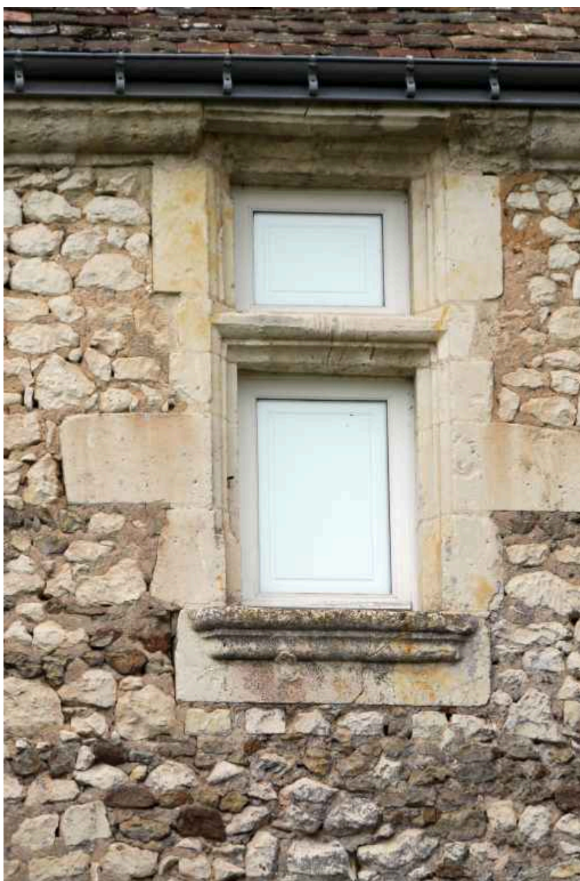
Le logis façade postérieure : demi-baie gauche.
