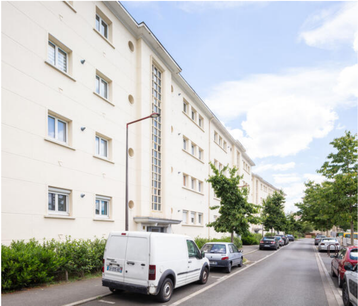
Vue du bâtiment C rue Régine-Deforges.
