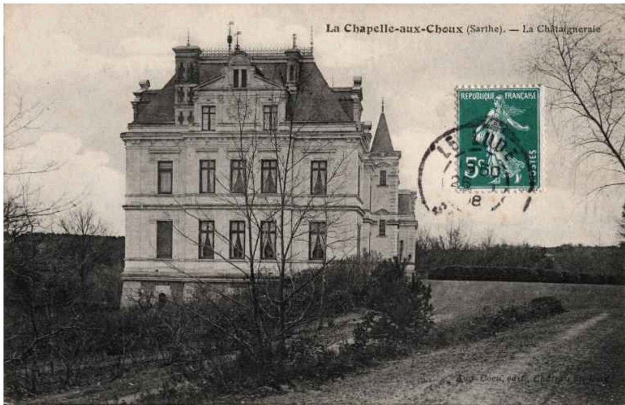
Vue générale de la façade ouest.
