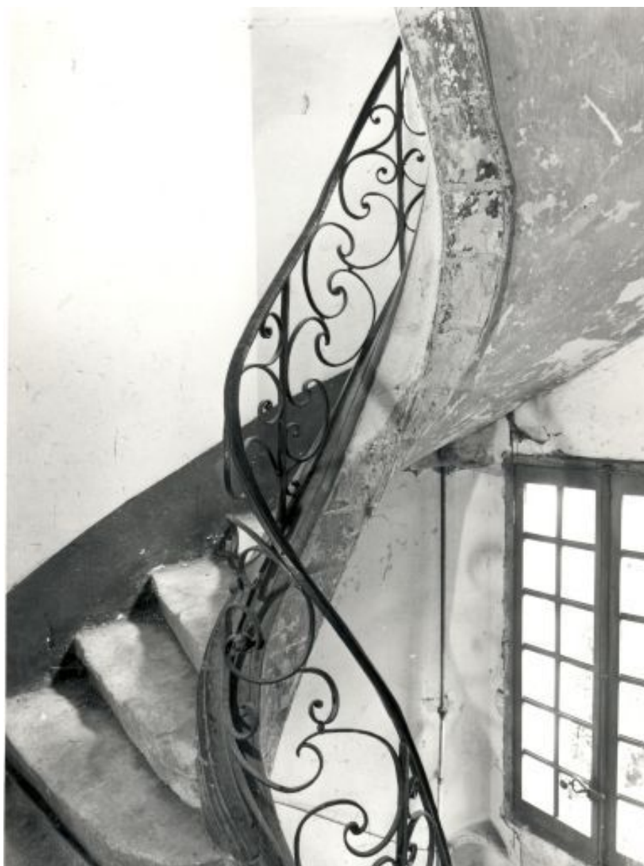
Escalier, 1ère volée.
