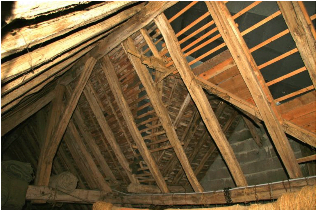
Habitation 3, pignon ouest : autre charpente.
