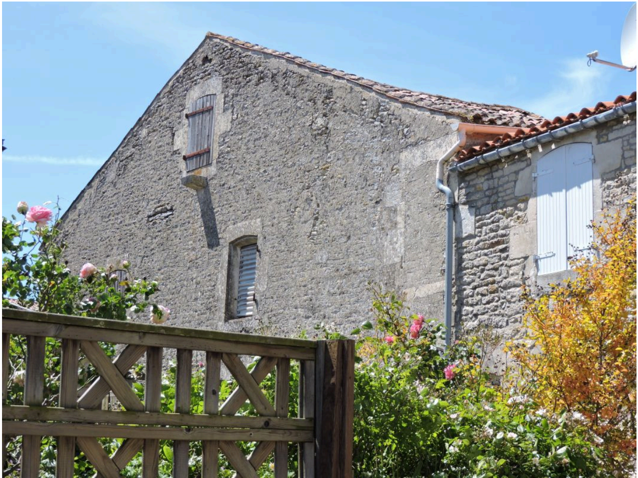
La façade de l'ancienne maison, sur le mur pignon, vue depuis le nord-est.
