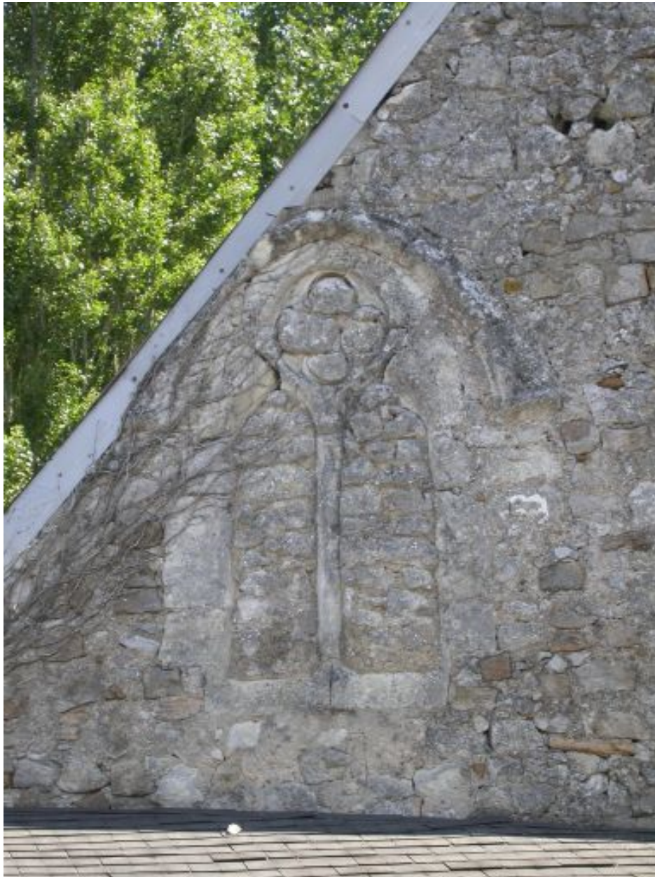
La baie quadrilobée.
