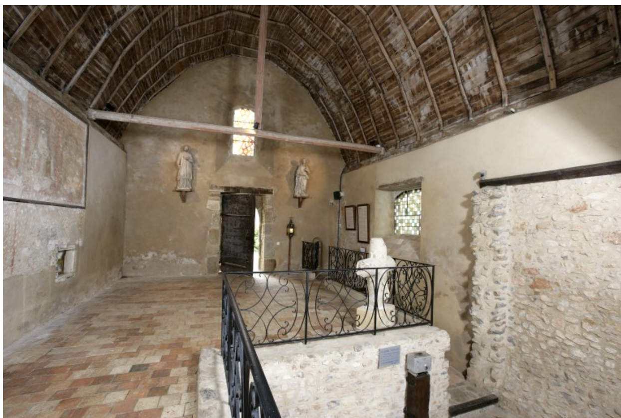
Vue intérieure de la partie XVe depuis le nord.
