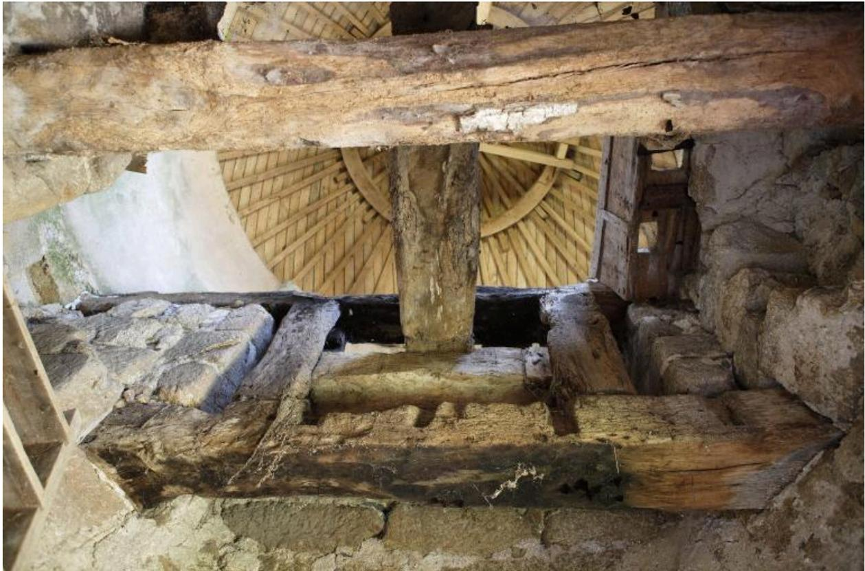
Intérieur. Charpente de la trempure, détail du cadre nord, avec le palier et son point d'appui. Vue de bas en haut. À droite, huche de réception de la farine avec les deux emplacements des goulottes servant à descendre la mouture à l'ensachage.
