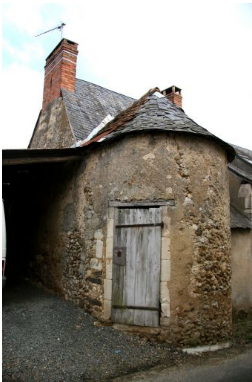
Tourelle d'escalier sur le chemin du cimetière.
