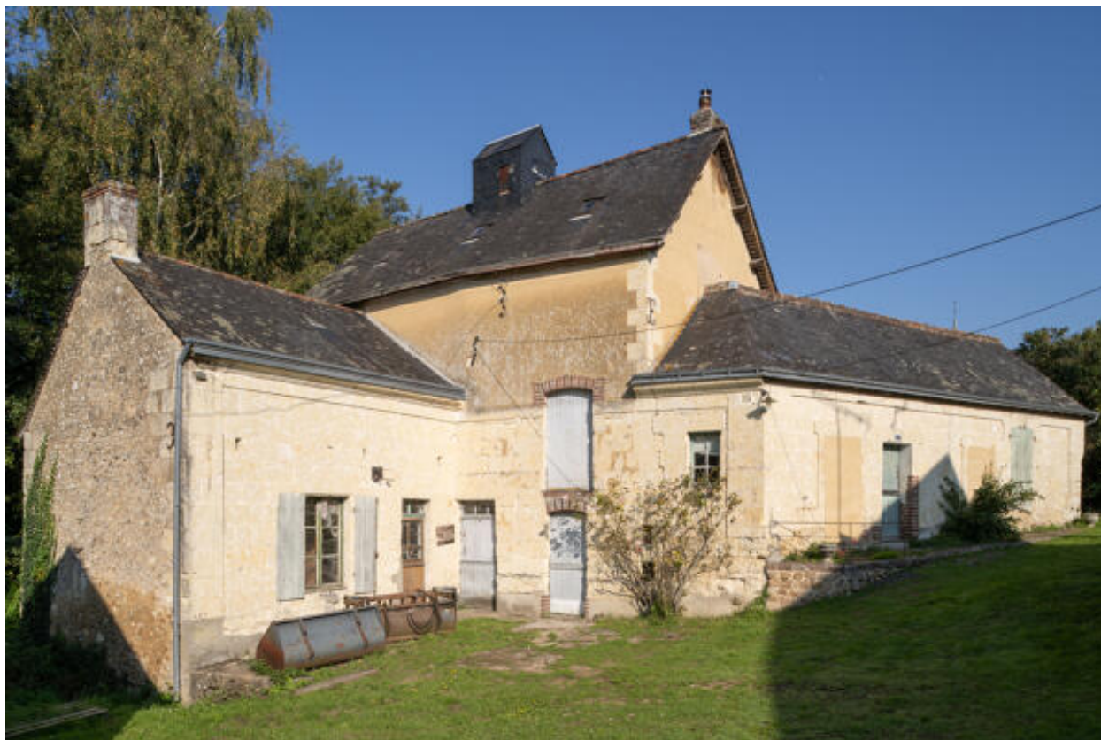
Bâtiment principal, abritant les logements et les machines.
