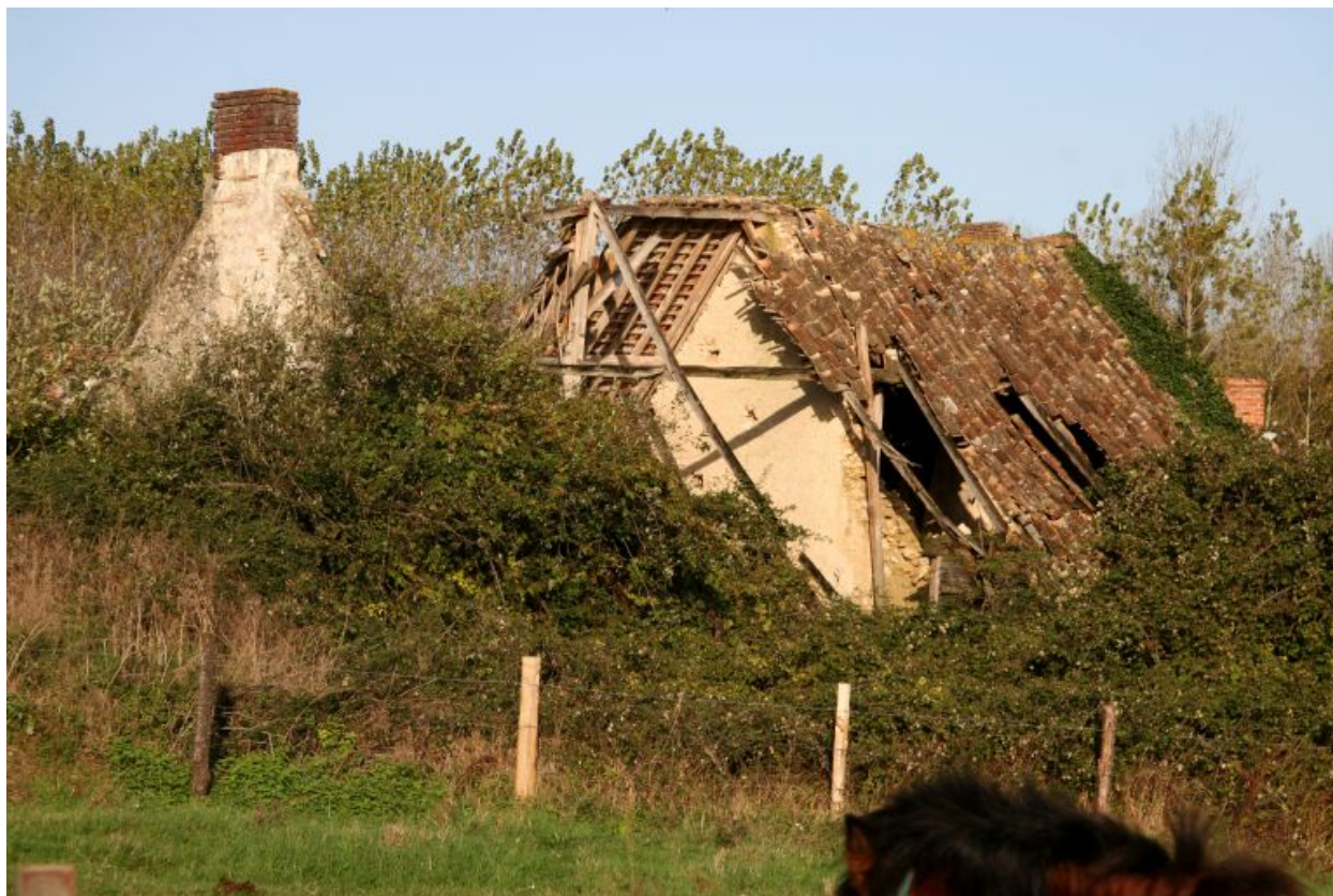
Vue générale d'une maison et grange sous un même toit couvert de tuiles courbes.
