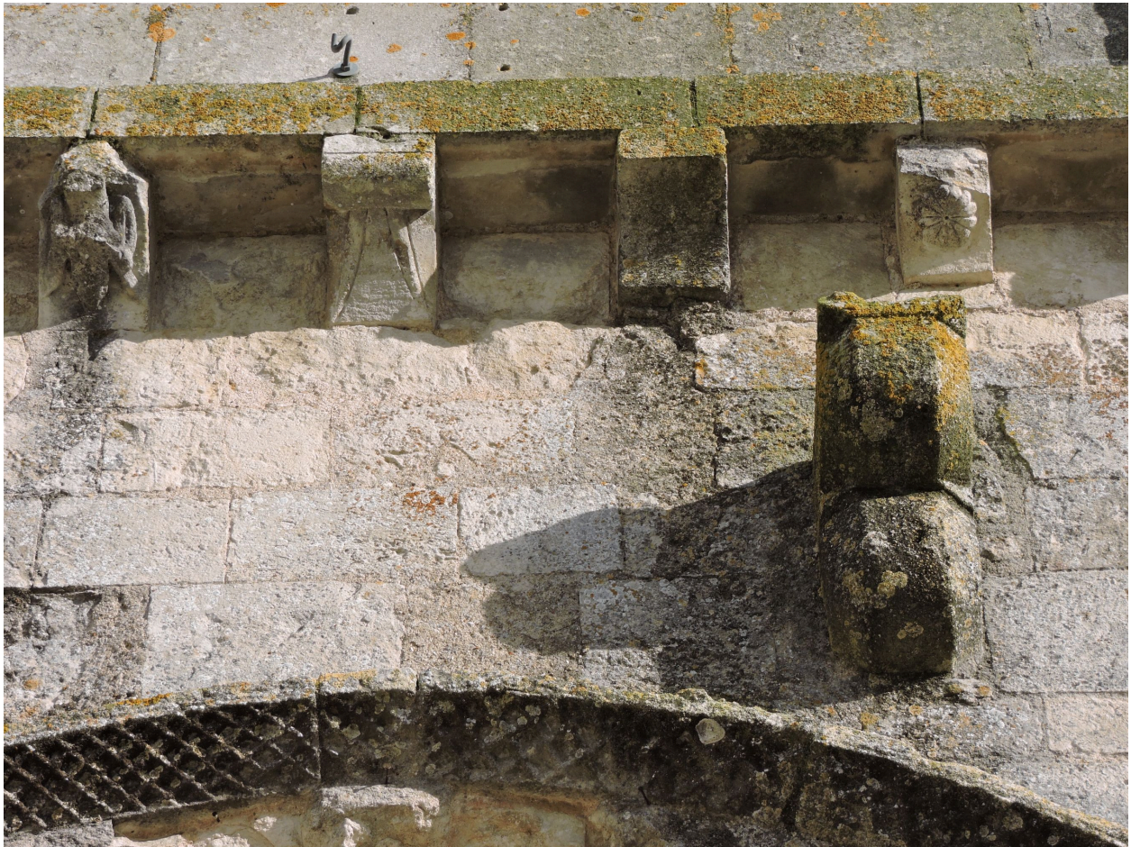
Corniche à modillons et corbeaux au-dessus du niveau inférieur de la façade occidentale.
