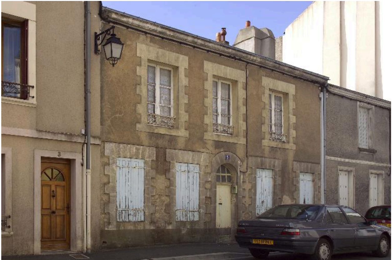
La maison n° 5 rue Pierre-Jubau.
