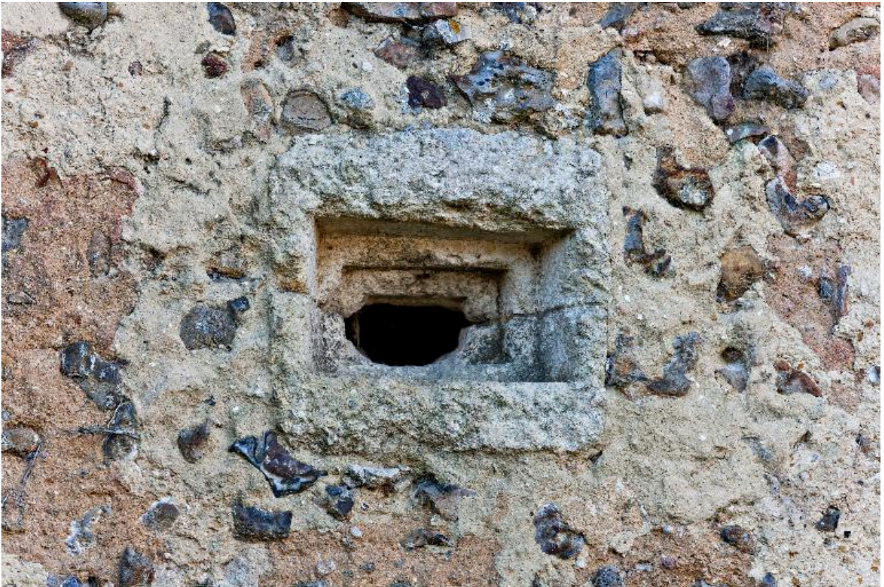
Canonnière de l'élévation nord de la nef, 1590.
