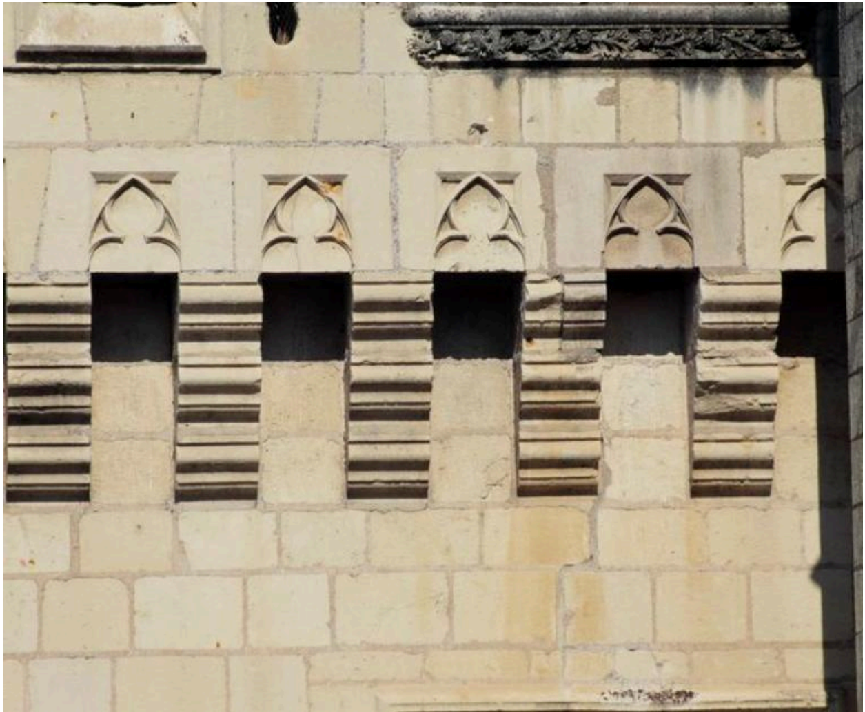
Mâchicoulis (1), corps principal, façade sud, partie est.
