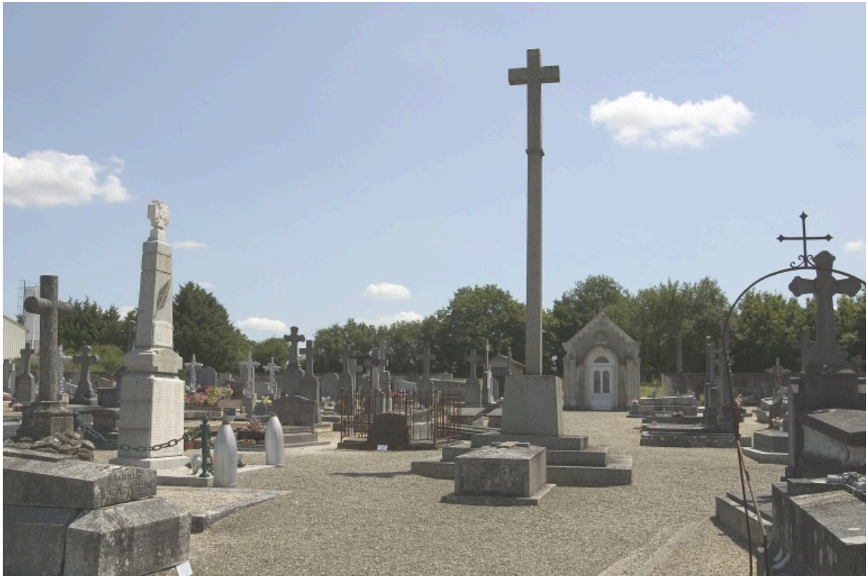
La partie centrale du cimetière : monument aux morts et croix cémétériale.
