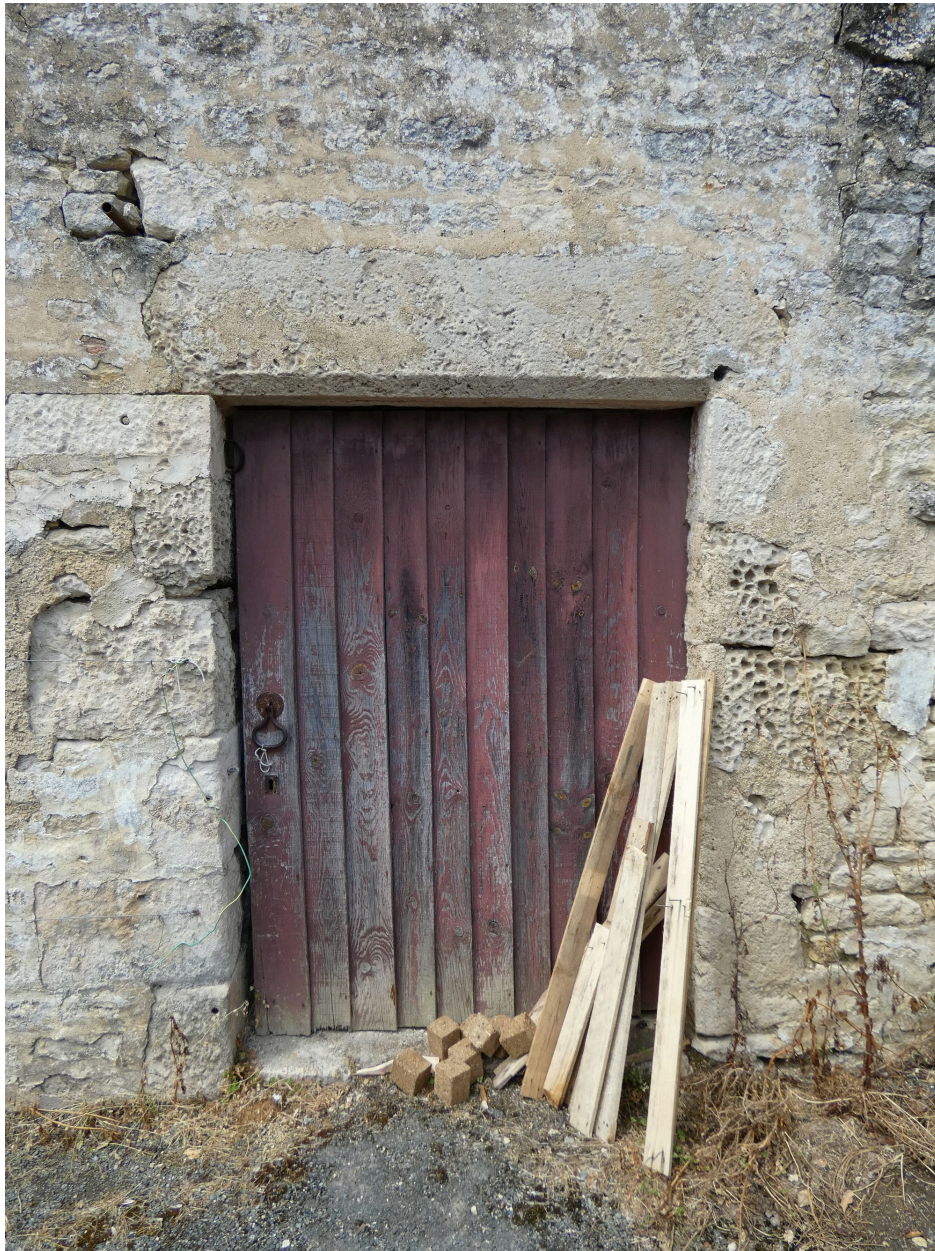
La porte de la remise, à linteau chanfreiné.
