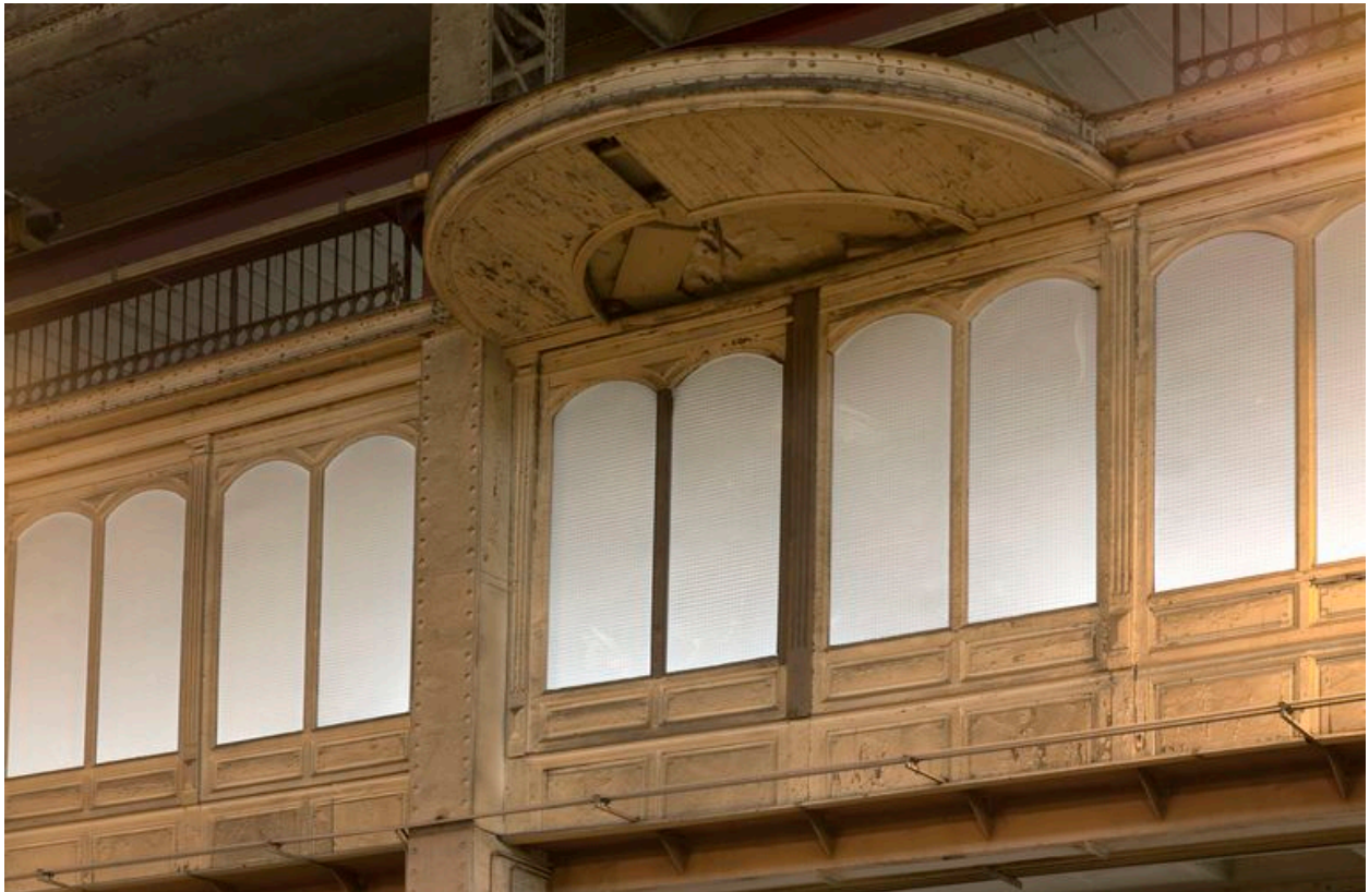
Détail de la galerie fermée de menuiseries du bas côté nord.
