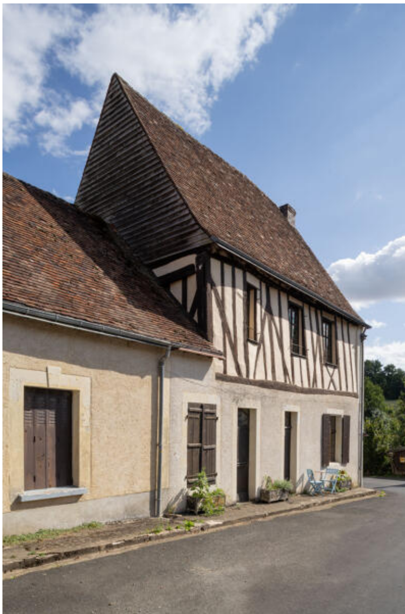
Vue du logis depuis l'est.
