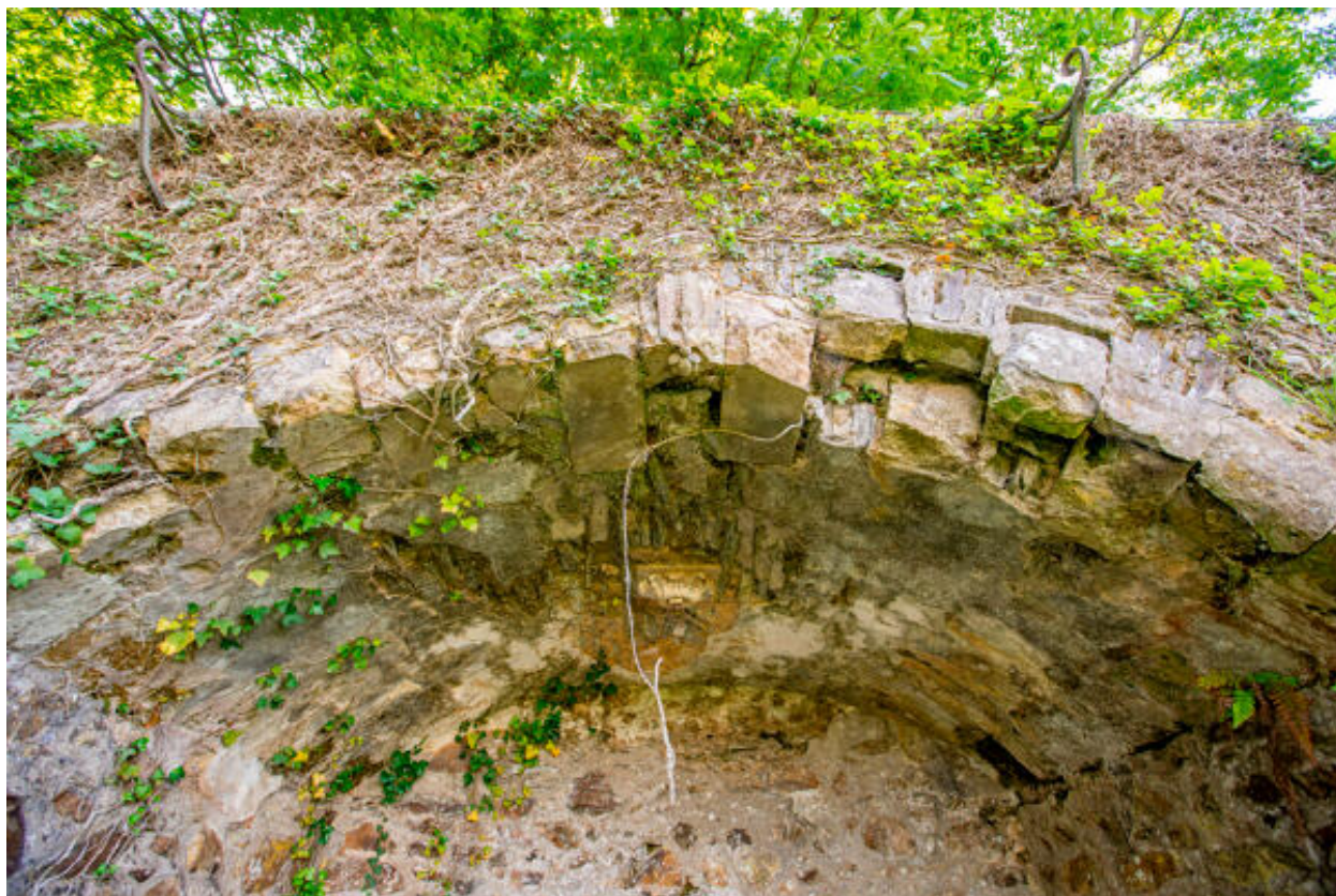
Un détail d'une alcôve sous le belvédère.
