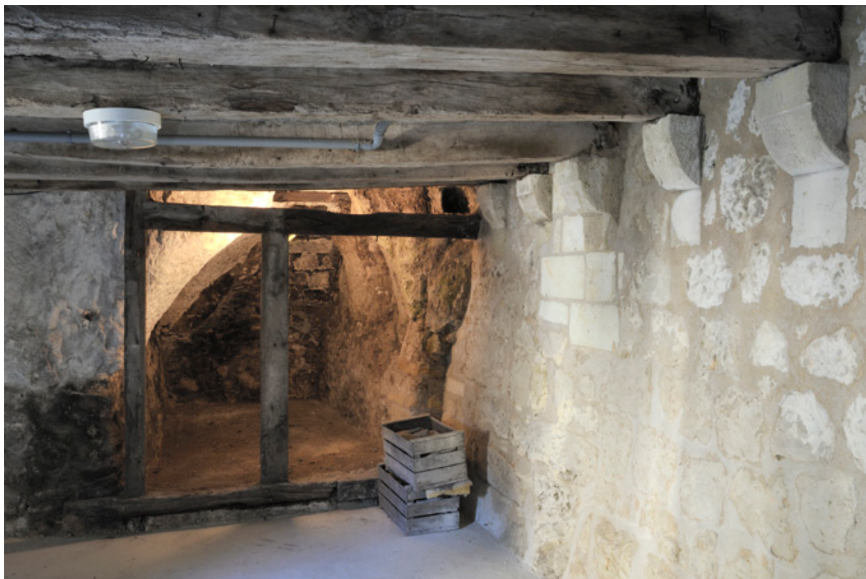
Cellier de la maison centrale, à flanc de coteau
