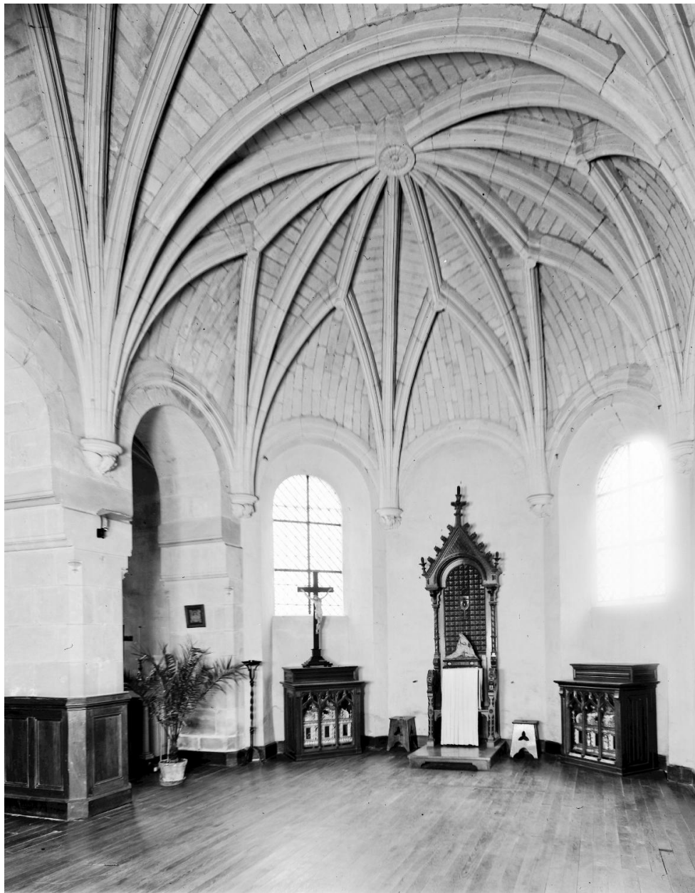
Eglise, chapelle de Guéméné : travée d'abside, vue d'ensemble.
