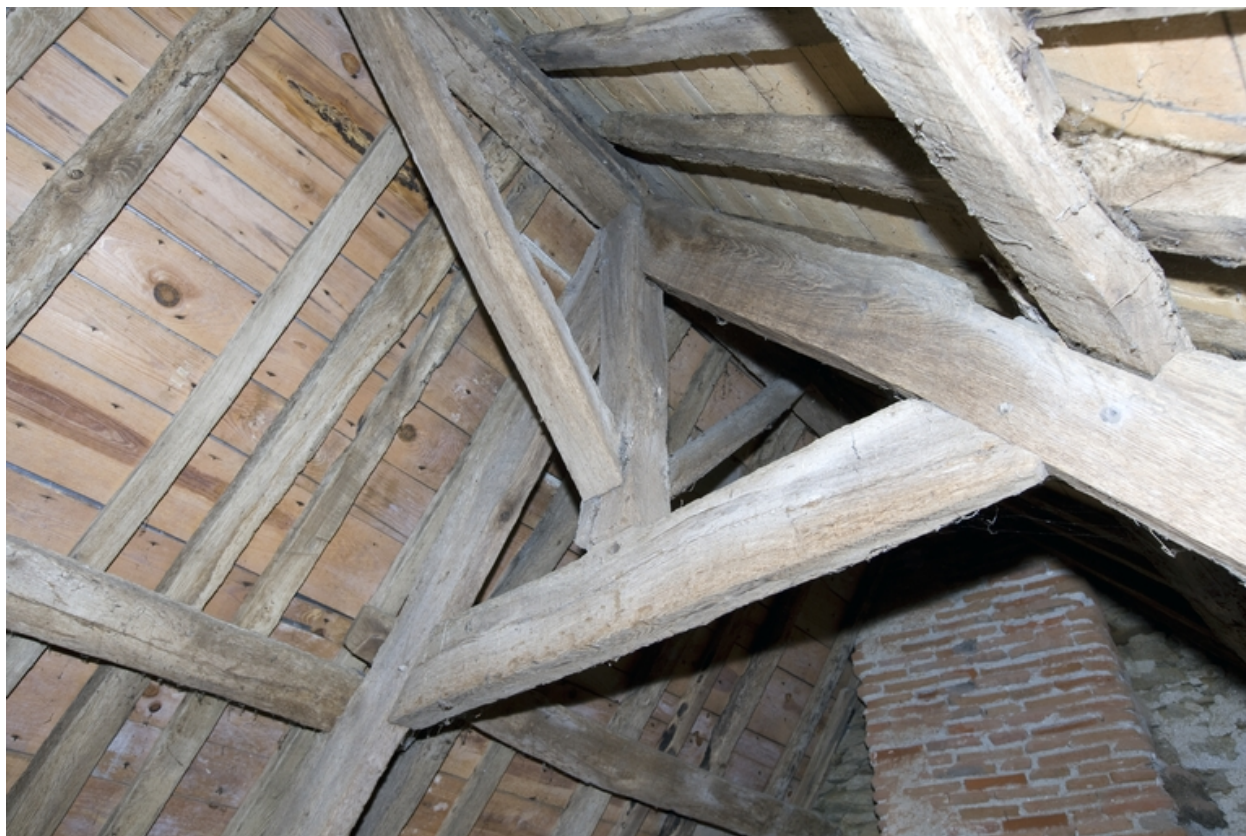
N° 10 rue Basse. Charpente.
