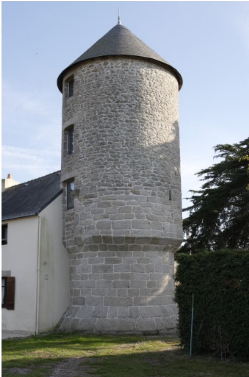
Moulin, vue d'ensemble depuis le nord-ouest.
